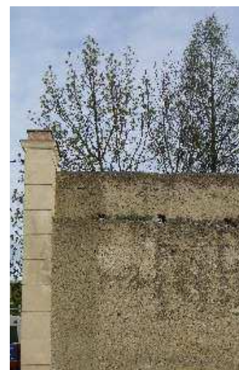
Unsere Stadtmauer wieder im ursprünglichen Erscheinungsbild.
